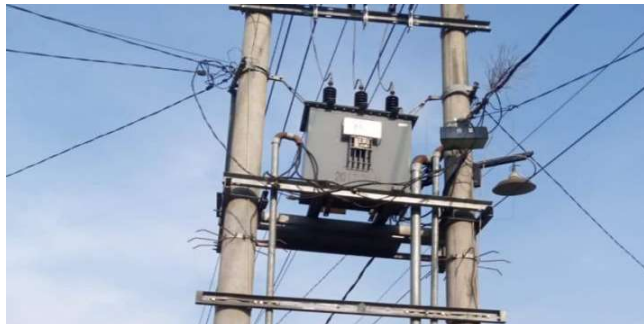
Gambar 14. Pemasangan alat deteksi
