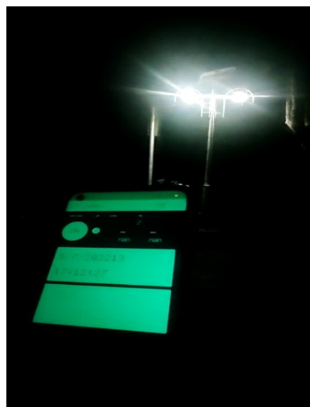
Gambar 5. Pengukuran lampu taman tenaga surya
